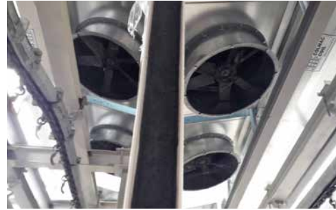
Ventiladores en tubos axiales para alta caída de presión estática externa (ESP)
