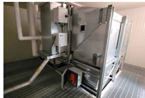
A+L 90° descarga vertical (unidades penthouse)
